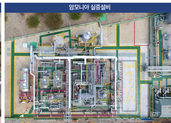
> 2024년 완공 | 암모니아 추진 핵심기술(연료공급, BOG 재액화, 배출저감) 검증 및 상용화를 위한 암모니아 실증설비 구축
