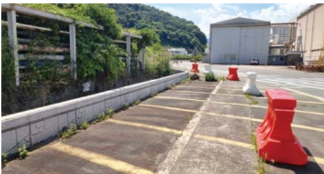
범람 취약 지역 차수벽 설치
